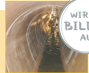
Fertig saniertes Eiprofil in Indien
