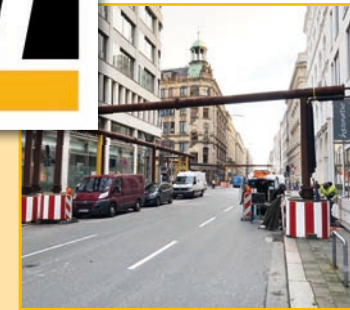
Wasserhaltung mit aufgeständerter Rohrbrücke
