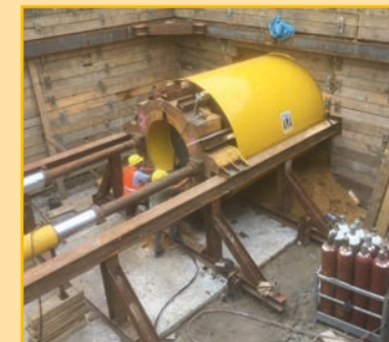
Rohrvortrieb im Zuge einer Erschließung
