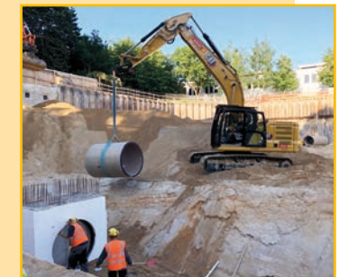
Kanalneubau und setzen eines Schachtes
