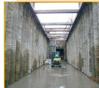
Baugrube mit Bohrpfahlwänden
